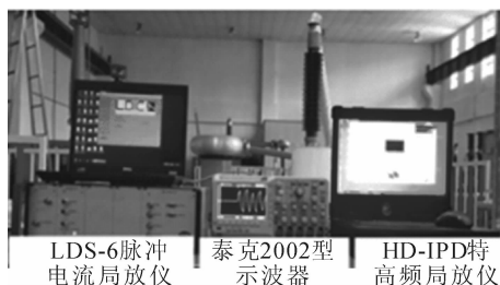
图3 局放检测系统实物图
